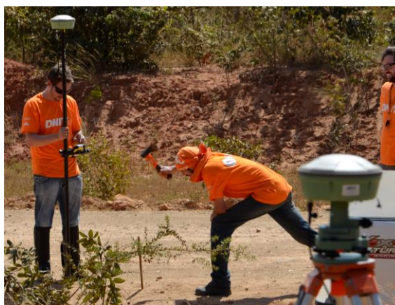
Figura 2 - Execução da locação das linhas.
